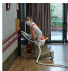
屋内消火栓操作訓練
